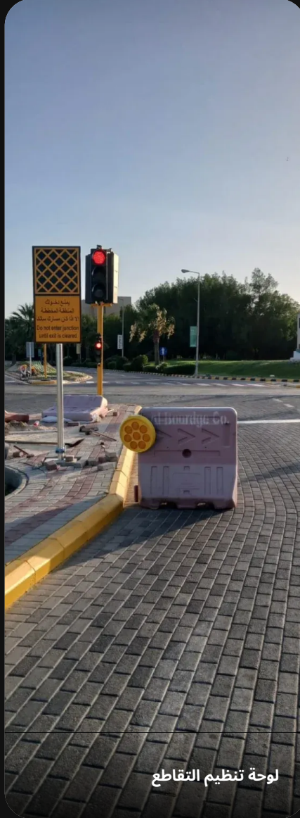
أعمال الموقع أثناء التنفيذ
